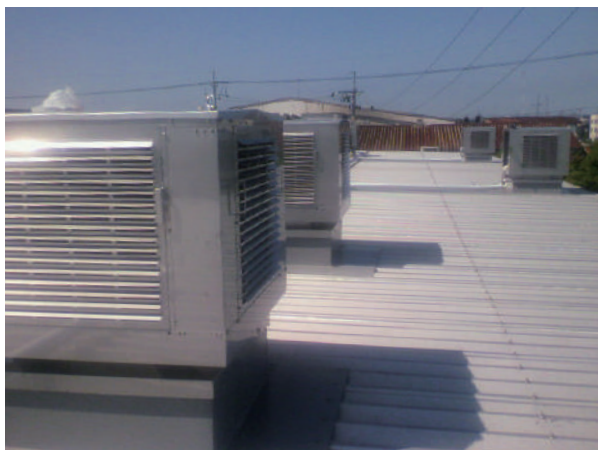
屋上取付け 折板屋根
