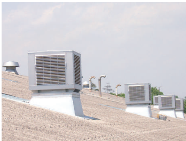
屋上取付け スレート屋根
