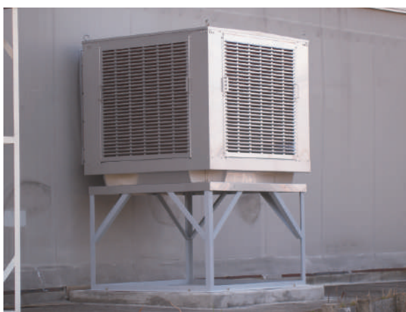
壁面取付け テント倉庫
